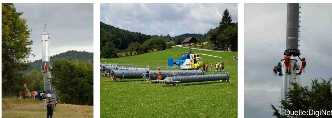
Maßarbeit dank Helikopter: Ein Digitalfunkmast wird aufgebaut.
